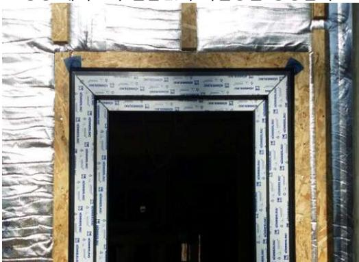
위의 사진2와 같이 팽창테이프를 여유있게 절단하지 않을 경우 모서리에 빈틈이 발생하여 폼이나 기타 기밀자재 등으로 일일이 메꿔줘야 하므로 시공에 불편함이 따르게 된다
